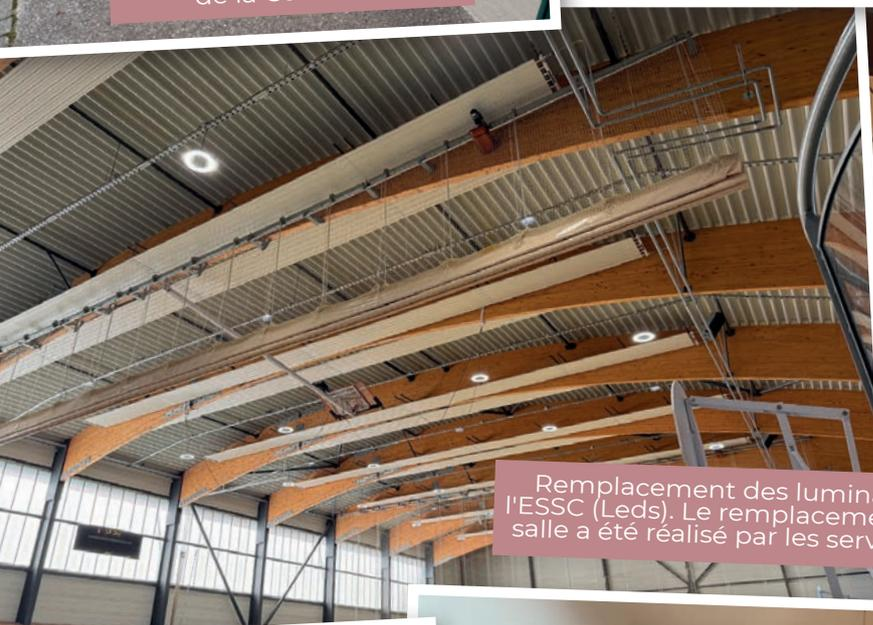
Remplacement des luminaires de la partie sportive de l'ESSC (Leds). Le remplacement dans les vestiaires de cette salle a été réalisé par les services techniques communaux
